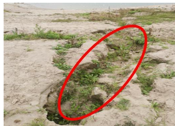
(6) 地表冲沟、山体渗水
