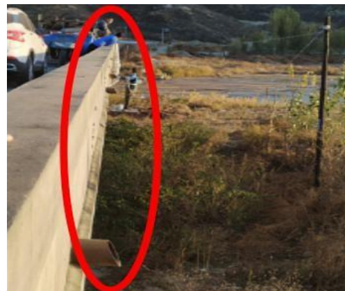
(3) 桥梁、道路、堤坝的纯雨水的小管、石缝口
